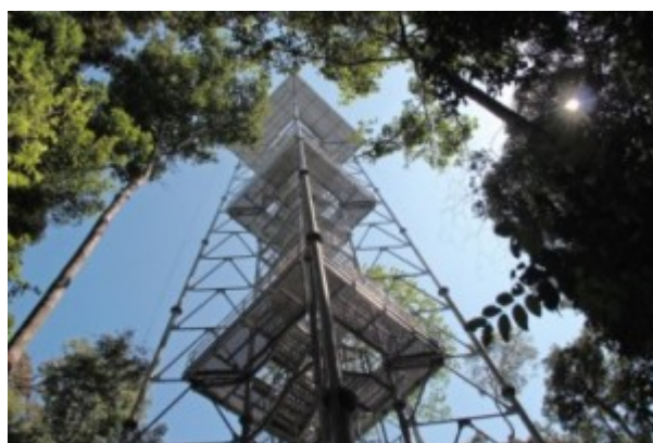
A estrutura da torre tem 42 metros de altura, com três plataformas. Foto: Eduardo Gomes/CIÊNCIAemPAUTA
